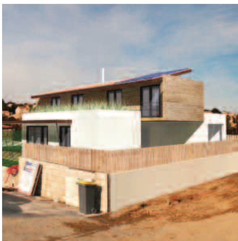
Dhominio RD a livré sa première maison en bois, modulable et économe en énergie, à un particulier de Pignan dans l'Hérault.
