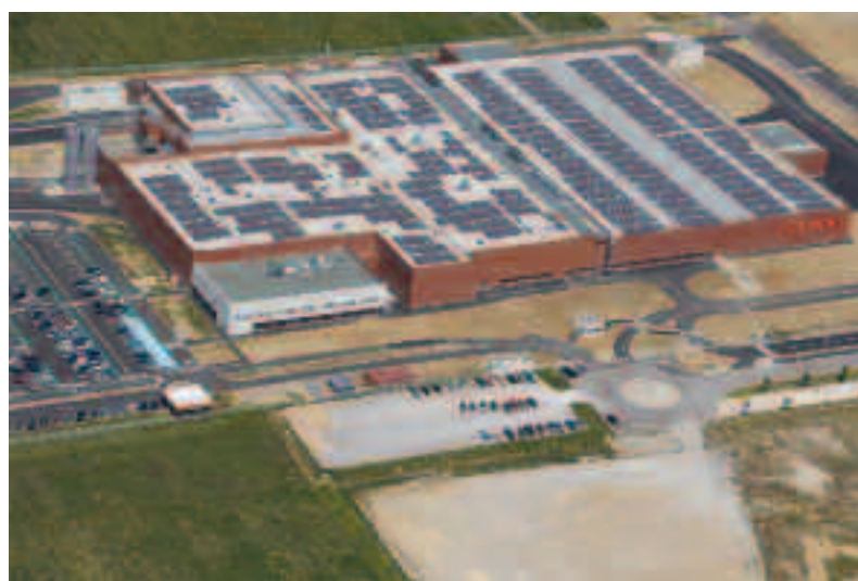
Sur le toit de la nouvelle usine de Perpignan, la plus grande surface de panneaux photovoltaïques de France, soit 11 000 m 2 !
